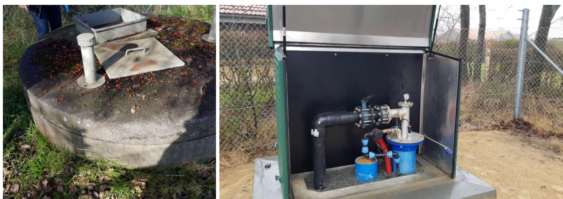
Figur 2-1 Før og efter billede af den renoverede boring DGU nr. 88.813 (B1).
